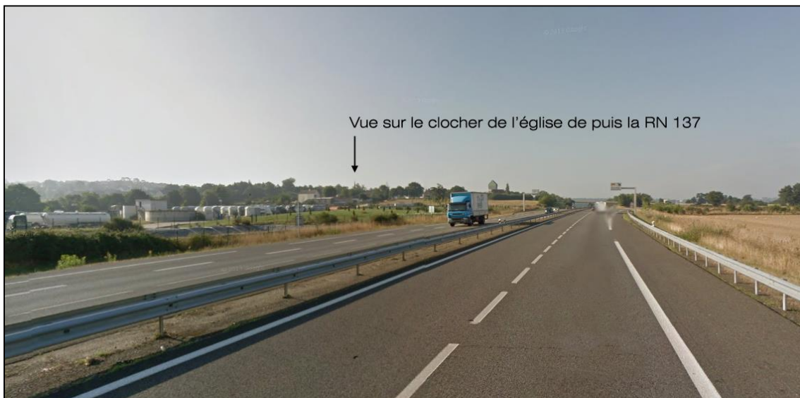
Vue sur le clocher (source : Google Streetview)
