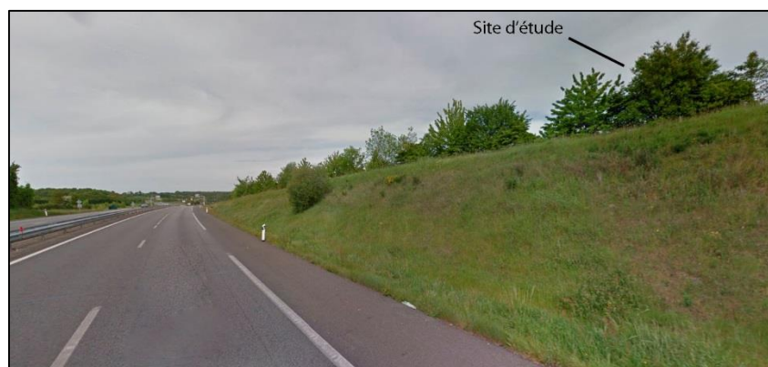
Vue sur le site en direction de Rennes
