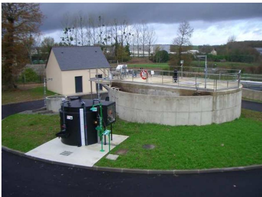
Photo 3 : Vue de la station d'épuration type « boues activées »
