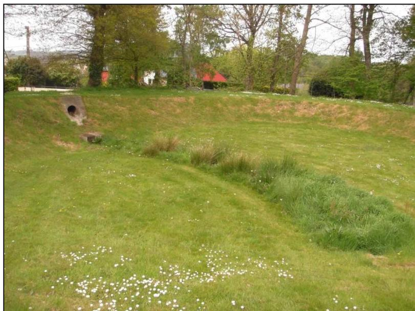
Ce bassin d'orage dispose d'un ouvrage de sortie conforme et un débit de fuite de 80 l/s (réseau Ø200 pour une hauteur de charge de 1,40 mètre).
