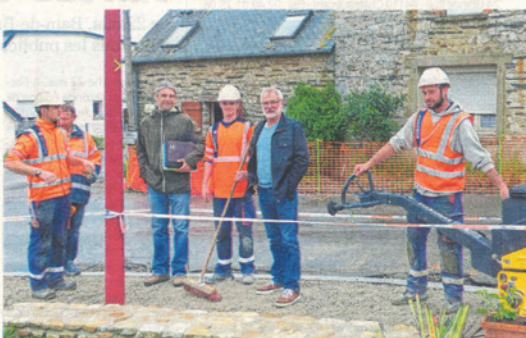
Le petit bâtiment, situé derrière le maire Guy Rinfrey et les responsables du chantier, va être détruit.
